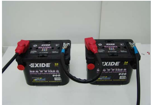
Fig. 6.10.2-4: Installation starter batterie
